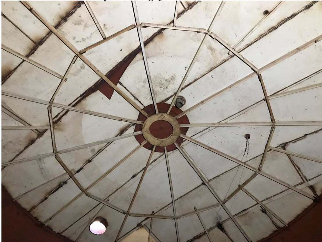
Mynd 1. Þak geymis
