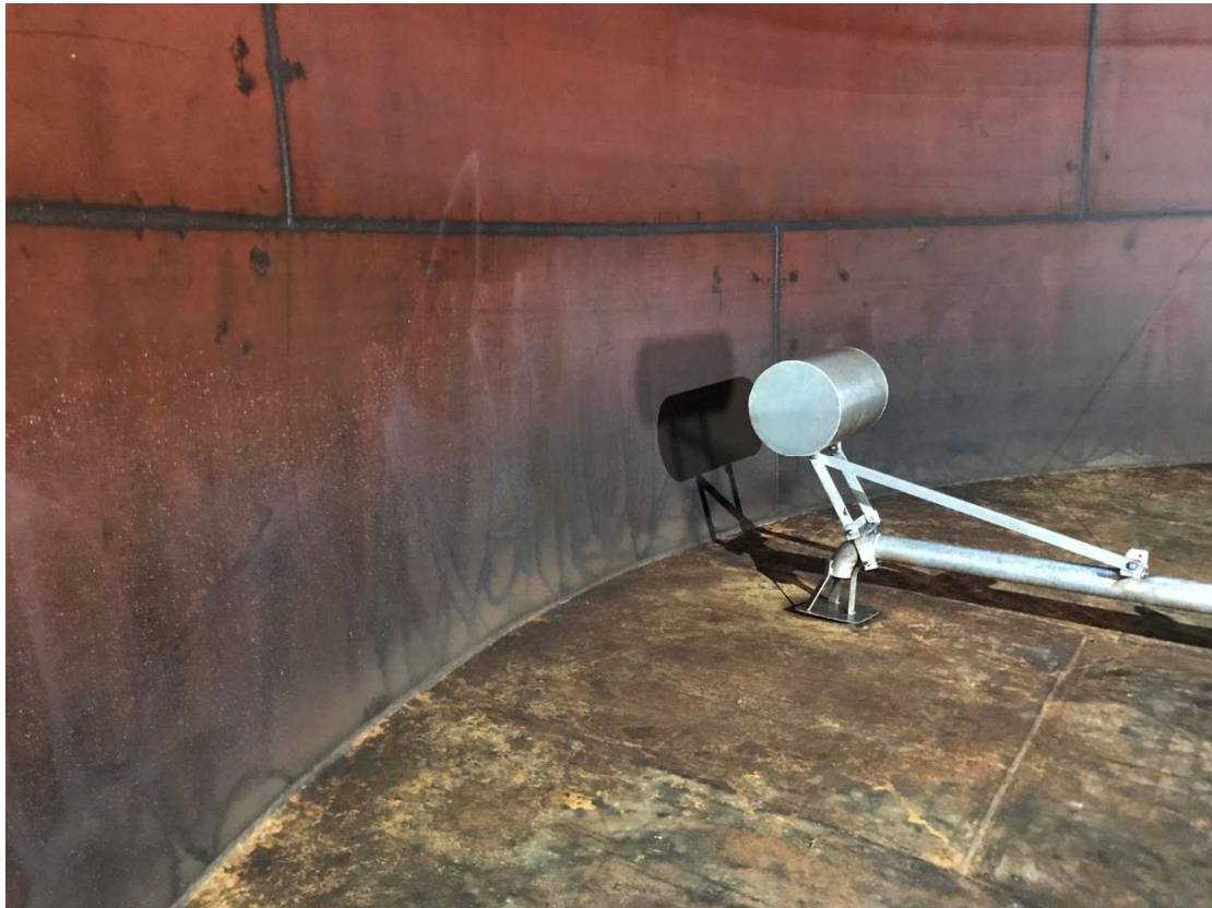
Mynd 3. Gólf er alsett tæringu en þó var um enga djúpa pytti að sjá.
